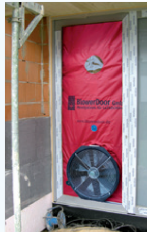
BlowerDoor test nove jednoporodične kuće
